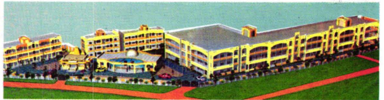
निर्माणाधीन युग निर्माण विस्तार भवन एवं प्रेस प्रशिक्षण भवन, गौशाला
